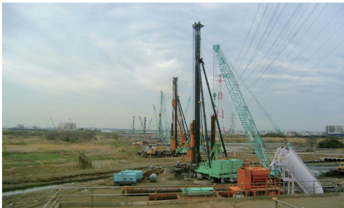
TAIP 工法施工機 5 台での施工状況
