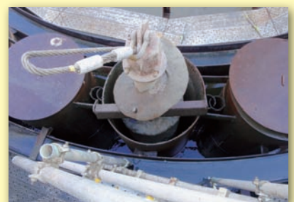
併合杭の沈設完了
