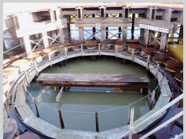
沈設後の全景
