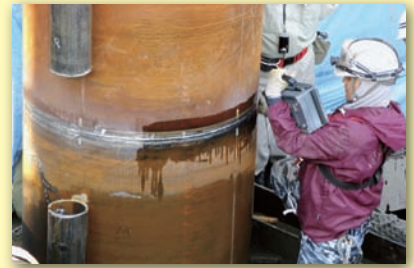
超音波探傷試験
