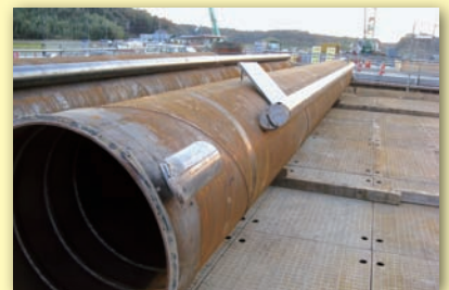
先端ガイド爪取り付け
