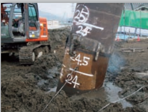
ヤットコ沈設
