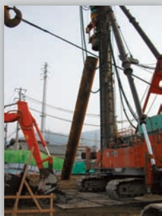
上杭建て込み
