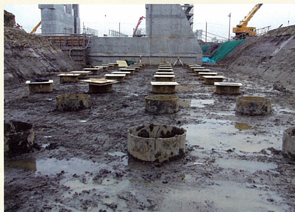
根切後の杭頭、杭芯状況
