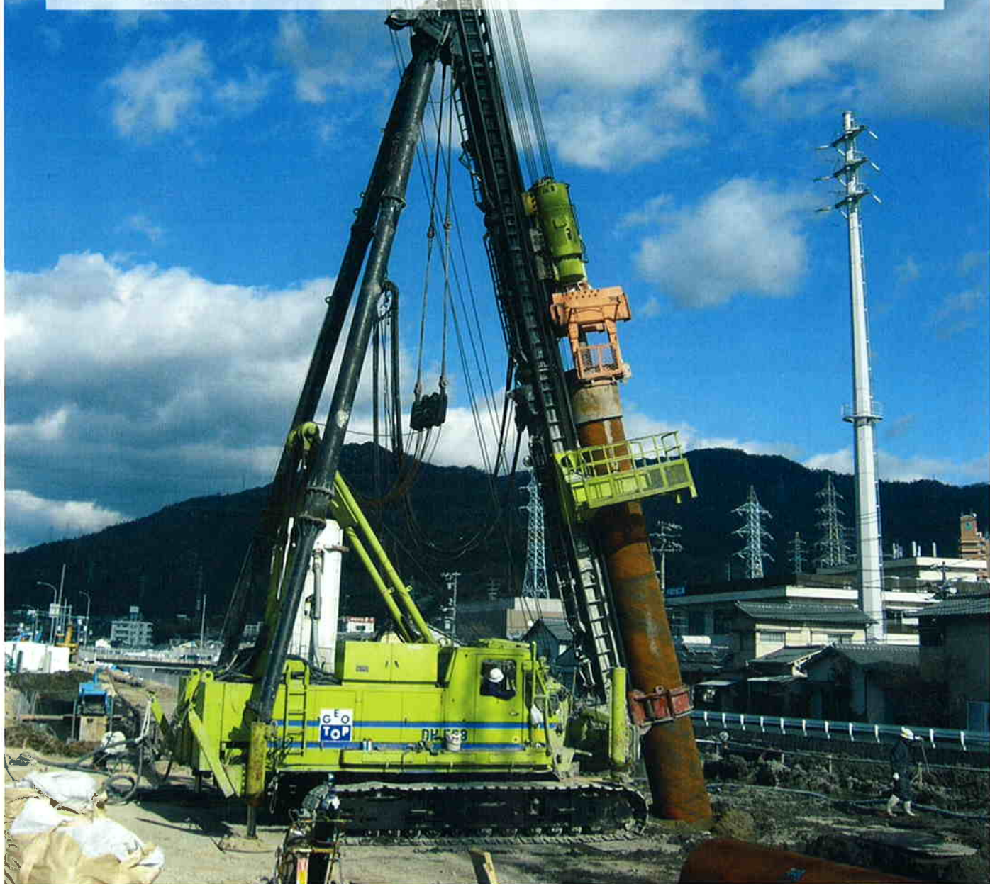
斜杭施工風景
