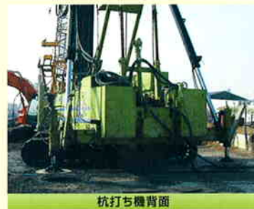
杭打ち機背面
