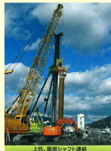
上杭、掘削シャフト連結
