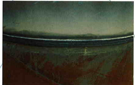
溶接後の外観
