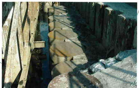
施工完了状況
