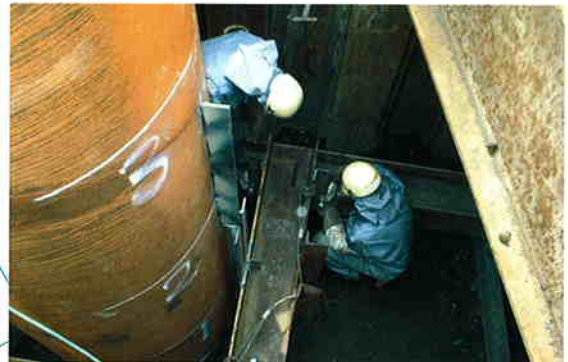
平板取付状況
