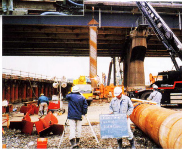
SPACE21工法による施工状況
