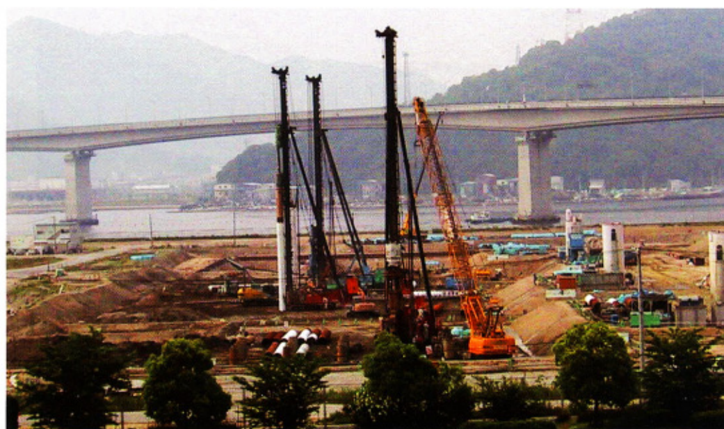
施工風景 (白い杭がSL塗布ぐい)
