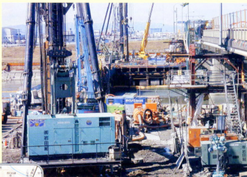
現場全景（右端は国道22号線の新名西橋）
