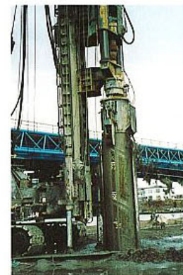
鋼管矢板沈設状況
