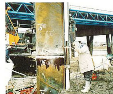
現場溶接部 連結継手管取付状況
