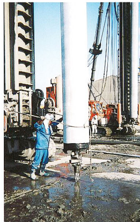
杭・ヘッドセット状況
