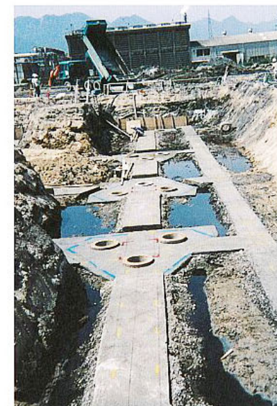
杭打設完了状況
