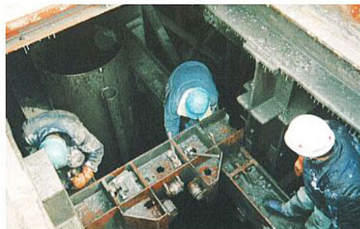
回転防止治具取付状況
