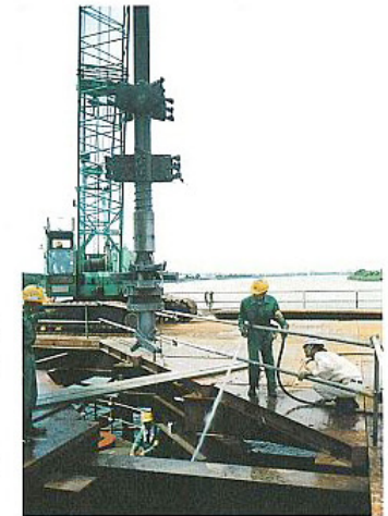
根固め用TAIPヘッド・シャフト (シャフトには管内清掃用ブラシを付けている)
