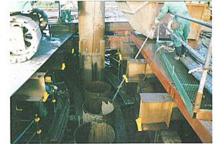
栈橋とヤットコ施工状況 (鋼管矢板の両側は導枠)
