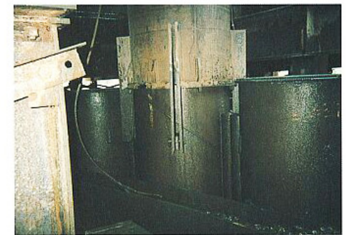
閉合杭止め状況 (ヤッコ装着状況)
