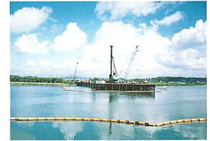
施工風景・汚濁防止フェンス
