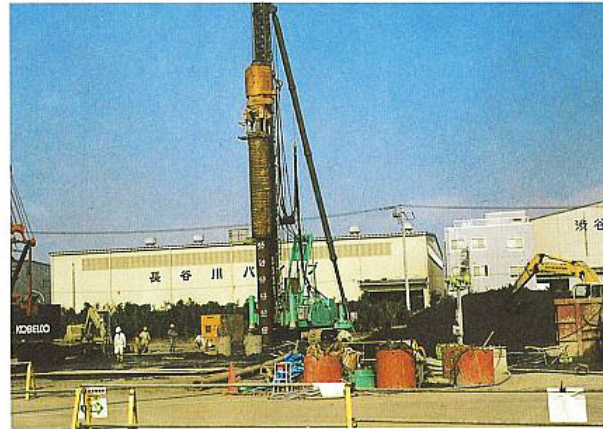
上杭施工状況
