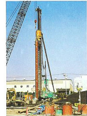
中杭セット状況
