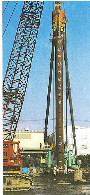
上杭溶接状況
