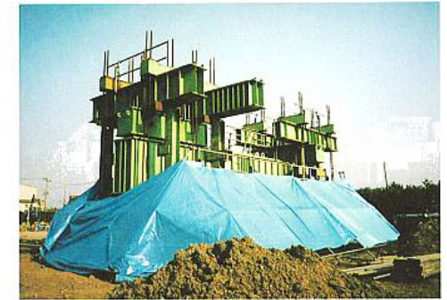
鉛直載荷試験状況
