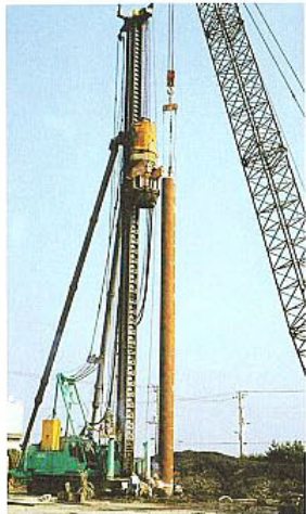
中杭セット状況
