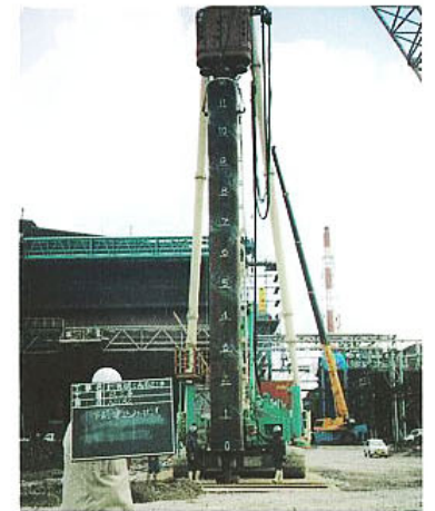
下杭 建込み状況 アースオーガー減速機 220H
