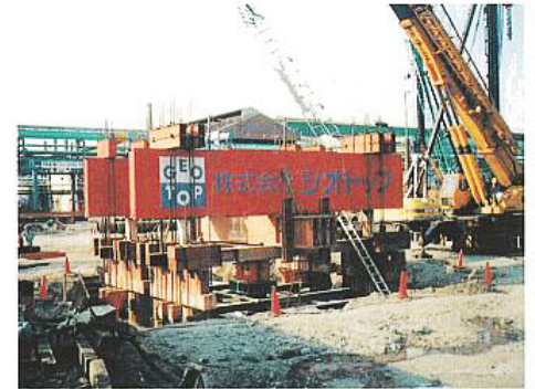
鉛直載荷試験 最大荷重 1400t (SPφ1,000 L=36.5m)
