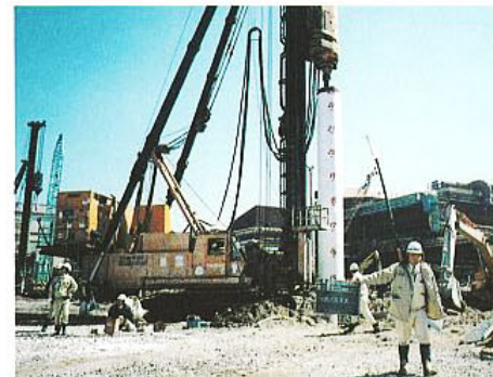
載荷試験杭 施工状況
