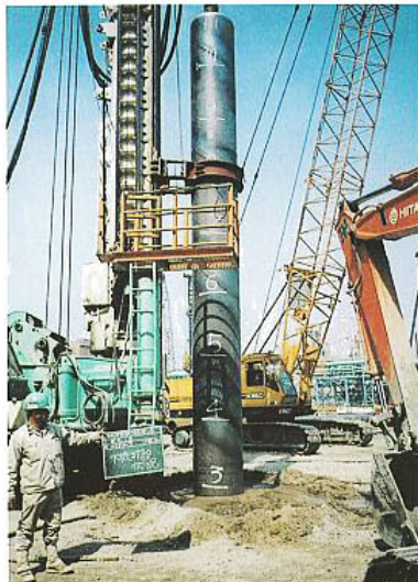
下杭施工状況
