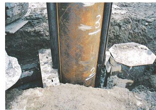
鋼管矢板沈設開始
