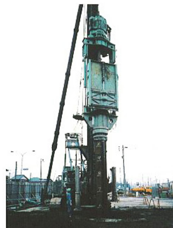
掘削圧入施工状況
