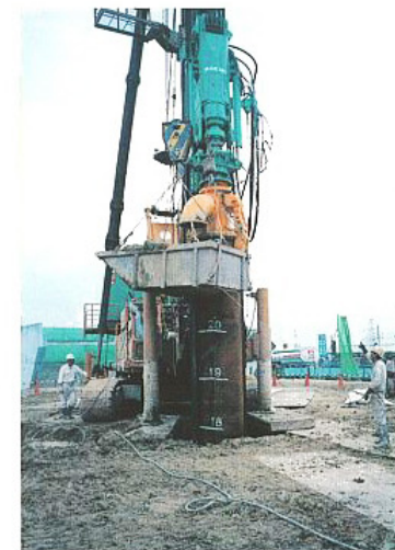
掘削圧入施工状況
