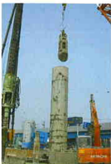
オールケーシング先行掘削
