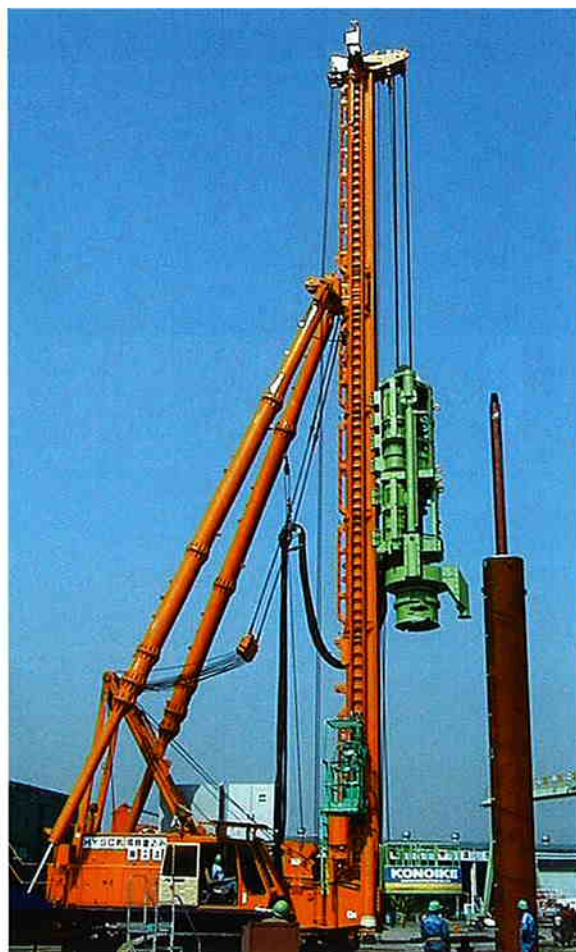
同時沈設施工法全景
