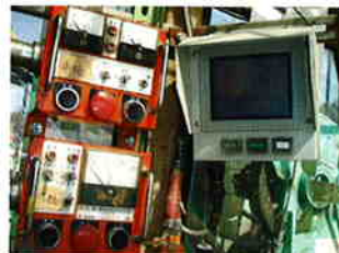
掘削攪拌機運転室
