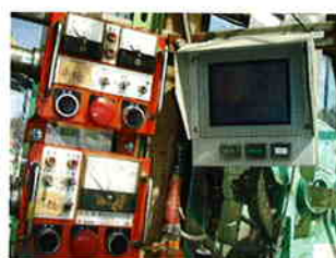
掘削攪拌機運転室
