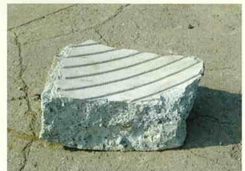
杭体ソイルセメント(深度20mより掘出し)
