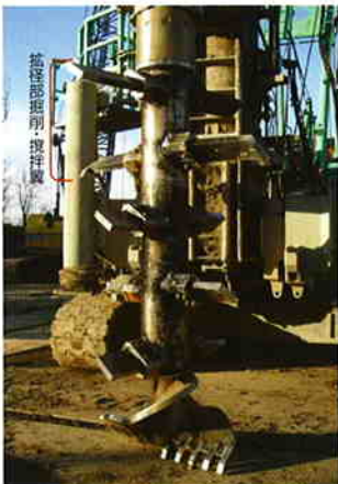
拡径部掘削・攪拌翼
