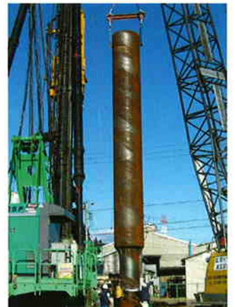
鋼管沈設
