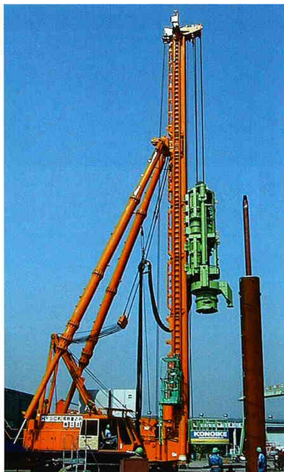
同時沈設施工法全景
