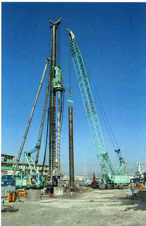
後沈設施工法全景
